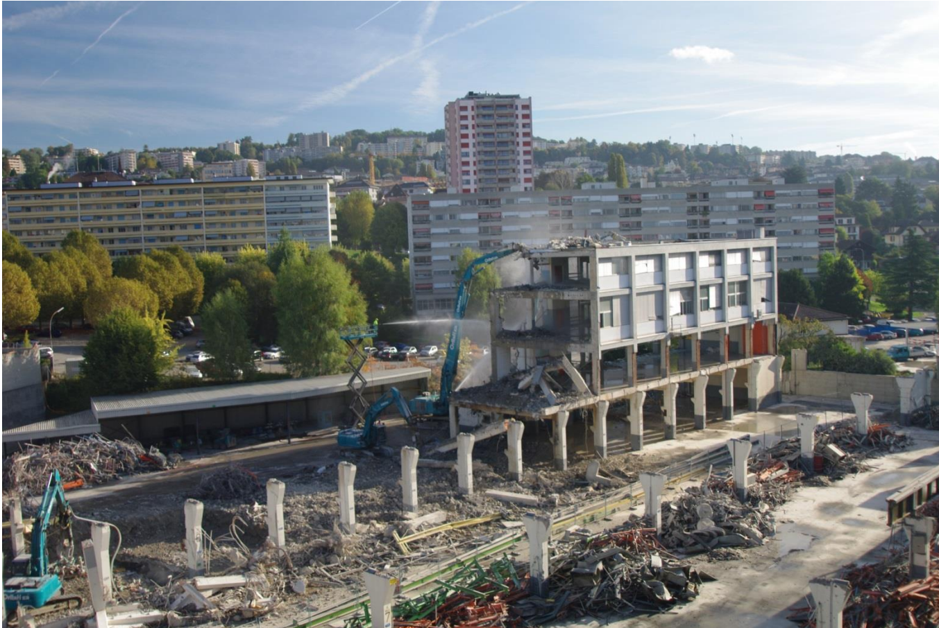
Déconstruction du site industriel Bobst à Prilly (2014)
